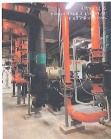
ระบบ Chiller และค่า Approach Temp Chiller 3.6 F
