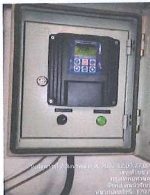
Conductivity Controller ไม่สามารถวัดค่าได้ เนื่องจากหน้าจอเสีย
