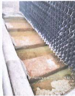
ถอด Cooling หลังทำความสะอาด
