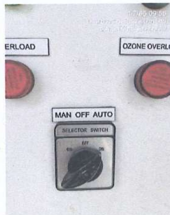
ตรวจเช็คระบบ OZONE ระบบทำงาน Auto ได้ปกติ
